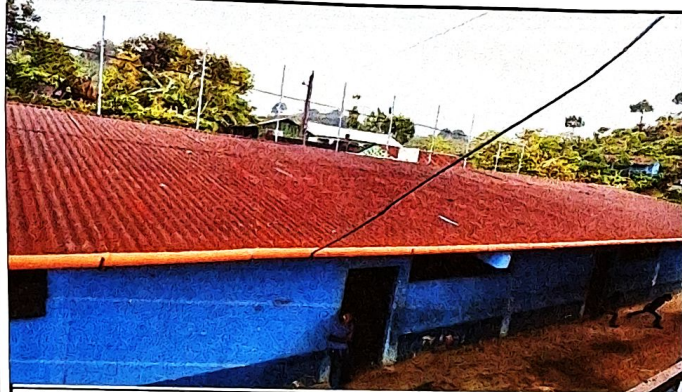
Foto 1: Sustitucion de lamina en mal estado por lamina troquelada en aulas.
