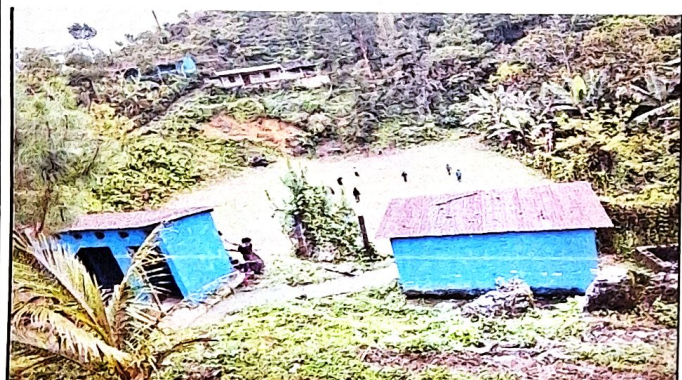
Foto 3: Sustitucion de lamina en mal estado de los inodoros
